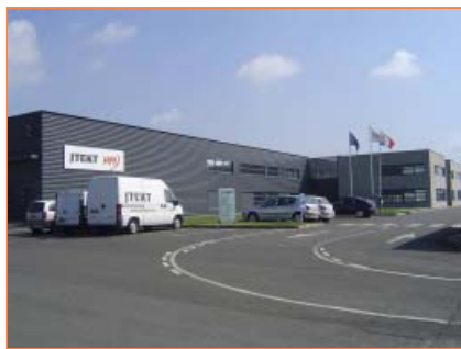
Blois plant Site de Blois (41) Werk in Blois
